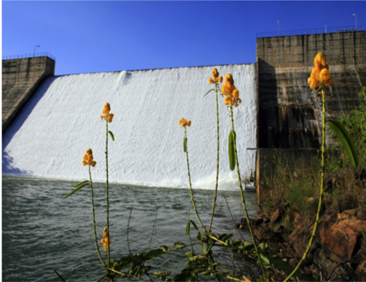
Barragem do Rio Descoberto
